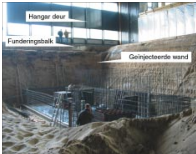
■ Figuur 2: Overzicht binnen de hangar
