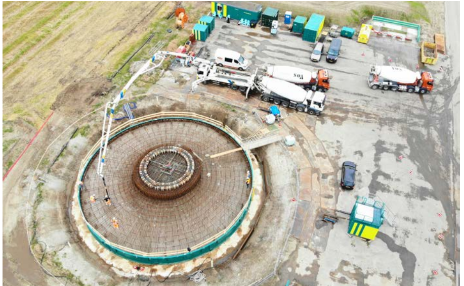
Impressie stortproces fundatie. (Foto's: Dura Vermeer)
